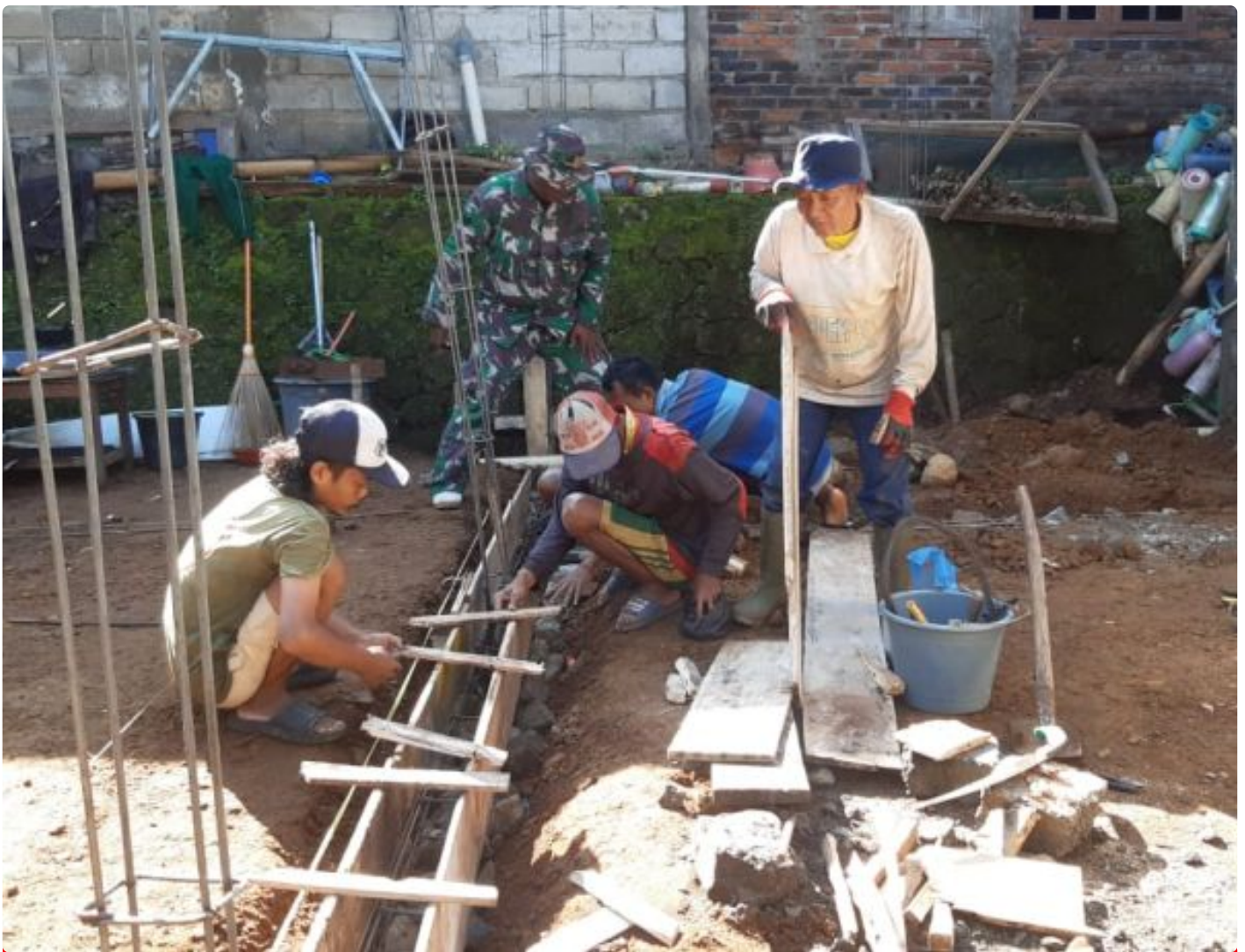
Pemasangan Bekisting Balok Sloof
